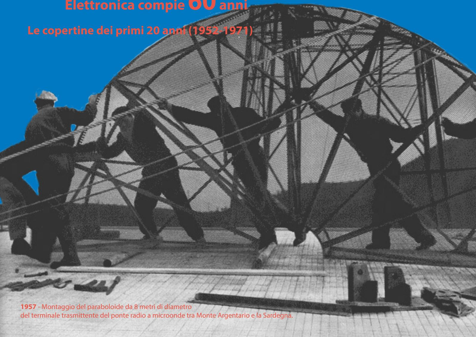
1957 - Montaggio del paraboloide da 8 metri di diametro del terminale trasmittente del ponte radio a microonde tra Monte Argentario e la Sardegna.
