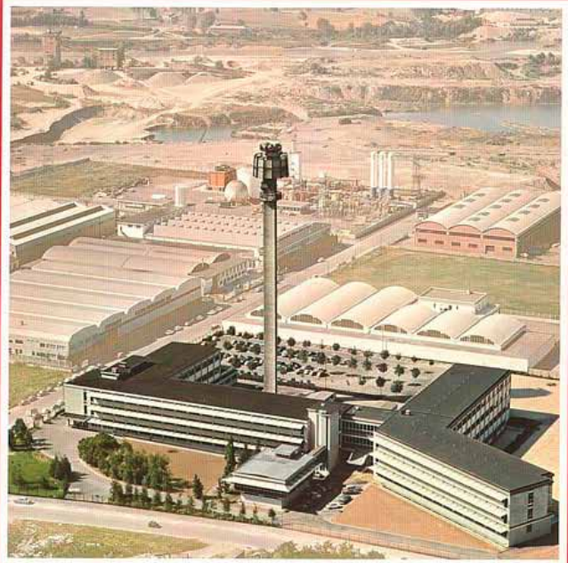
Veduta aerea dello CSELT - Centro Studi e Laboratori Telecomunicazioni (v. art. pag. 231).
