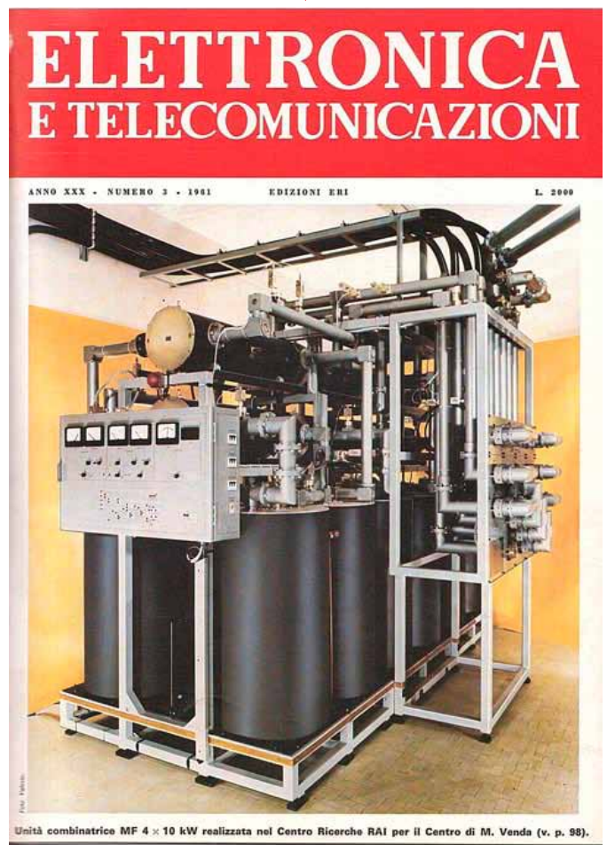
Unità combinatrice MF 4 x 10 kW realizzata nel Centro Ricerche RAI per il Centro di M. Venda (v. p. 98).
