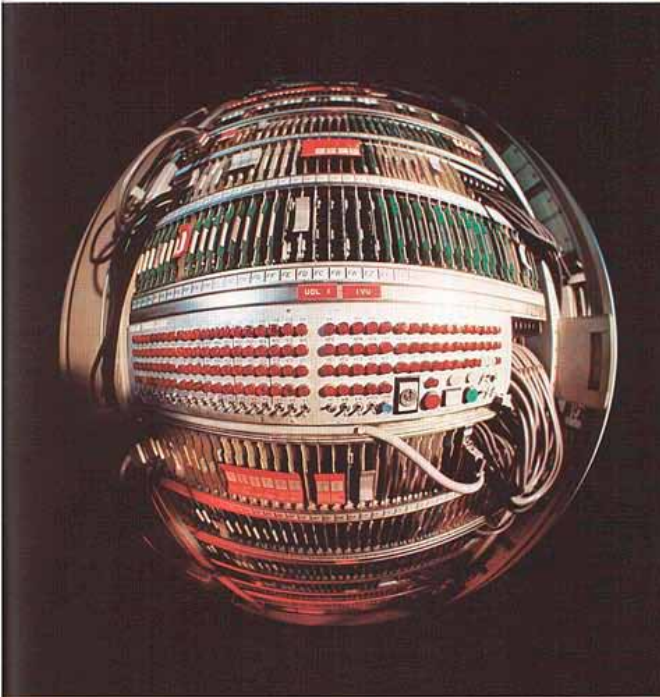
Sistema Proteo: Unità Controllo Linee della Centrale Terminale (v. articolo a pag. 11).
