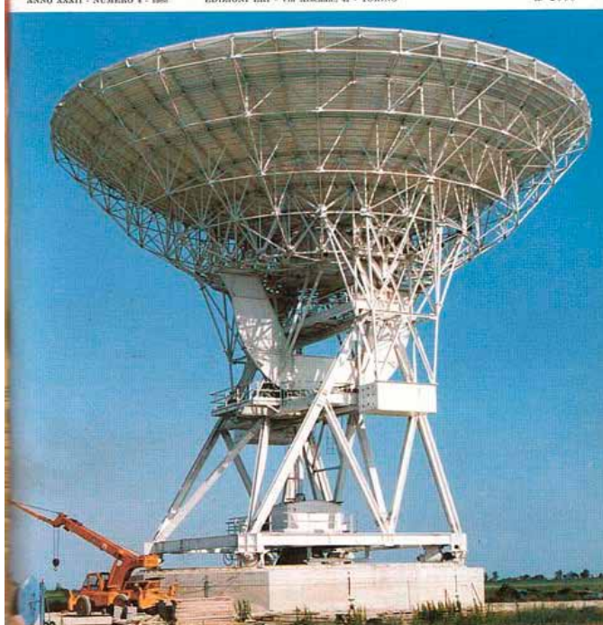
Antenna con paraboloide di 32 metri di diametro del radiotelescopio di Medicina (BO) (v. pag. 156).
