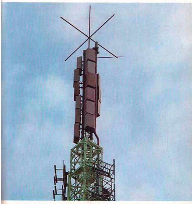
Sommità del traliccio del ripetitore di Foligno con le aste captatrici per rilievi sui fulmini (v. pag. 41).
