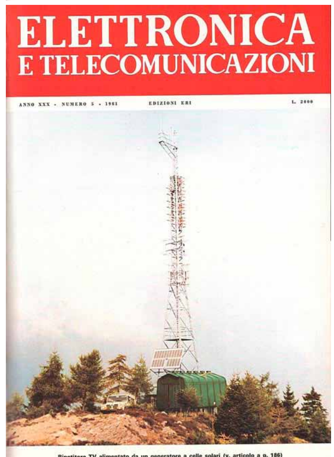
Ripetitore TV alimentato da un generatore a celle solari (v. articolo a p. 186)
