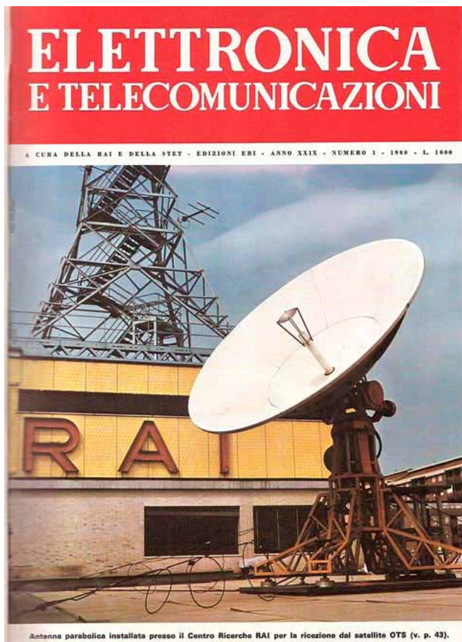
Antenna parabolica installata presso il Centro Ricerche RAI per la ricezione dal satellite OTS (v. p. 43).
