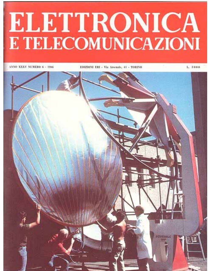
Montaggio dell'antenna con riflettore gonfiabile presso lo CSELT (v. art. a pag. 242).
