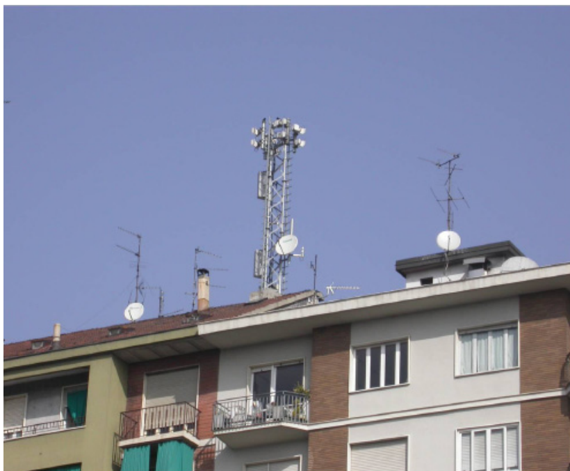
Fig. 3 - Impianti riceventi DTT in prossimità di una Base Station LTE.
