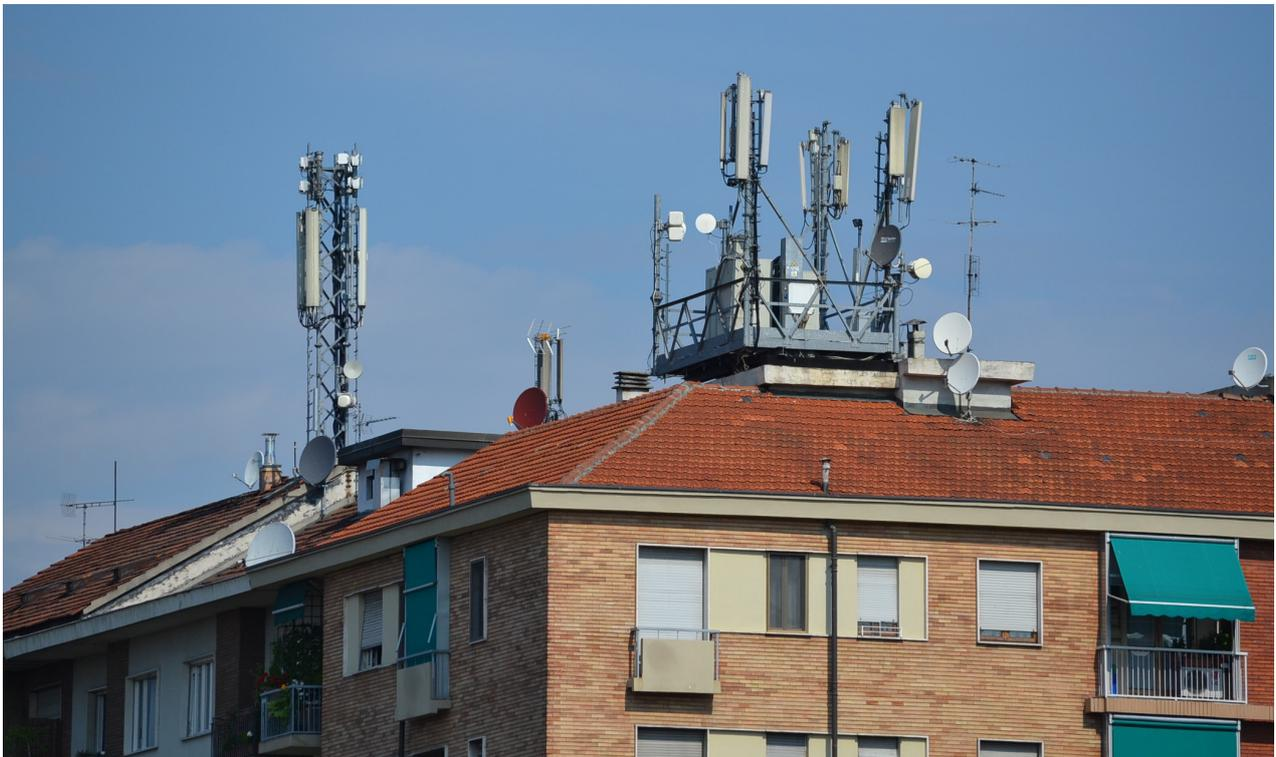
Fig. 1 - Impianti riceventi DTT in prossimità di una Base Station LTE.
