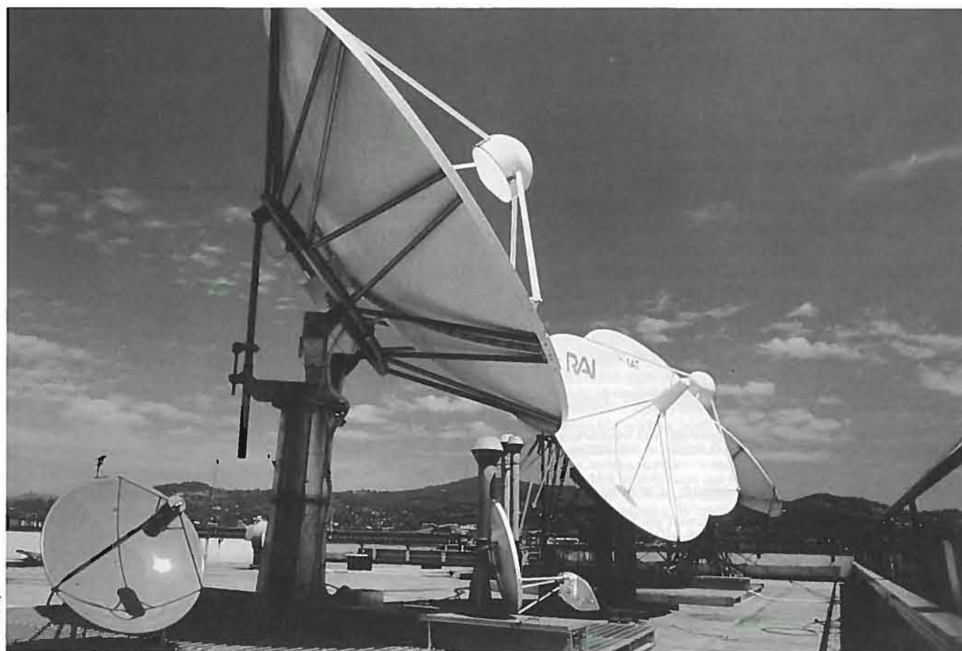
Fig. 2 — Antenne per la ricezione da satellite (poste sul terrazzo del Centro Ricerche RAI). Si noti la differenza di grandezza tra quelle per la ricezione di satelliti di collegamento tipo ECS e quella per la diffusione diretta da satellite DDS (la più piccola in basso a sinistra).
