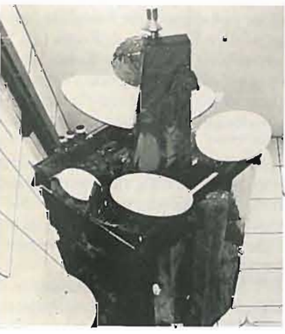
Satellite Olympus-F1 commissionato dall'ESA (Agenzia Spaziale Europea) alla British Aerospace come capo commessa. Alla Selenia Spazio è stato affidato il progetto e la realizzazione del carico utile (in particolare il payload per la diffusione diretta); altre importanti parti sono state commissionate all'Aeritalia. La foto mostra il corpo centrale del satellite Olympus-F1 comprendente i vari «payload» e le antenne: nel punto più alto l'antenna in banda S svolge funzioni di telemetria e telecomando. Dietro il riflettore ellittico dell'antenna trasmittente B1 (fascio italiano DBS) con a fianco i tre «horn» del pacco Propagazione. Davanti le due antenne del pacco 20/30 GHz; di fianco a sinistra l'antenna ricevente B3 per DBS. In basso a sinistra l'antenna trasmittente B2 (fascio europeo DBS). Dalla parte opposta si intravede il riflettore dell'antenna «multibeam» per Servizi Specializzati.
