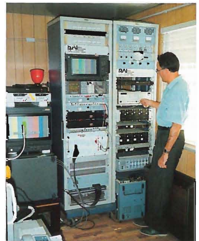
Fig. 4 — Apparati di codifica e controllo del segnale HDTV numerico presso lo Stadio Olimpico.
