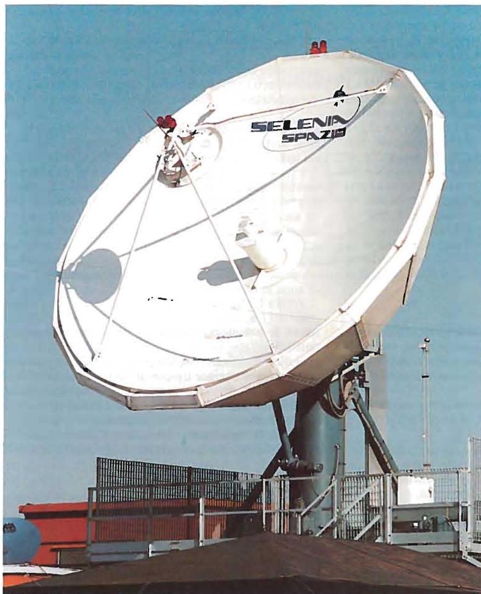
Stazione trasmittente fissa di Telespazio puntata verso il satellite Olympus e posta sull'edificio del Centro di Produzione TV della RAI a Roma. L'antenna ha un diametro di 6,1 metri, con illuminatore tipo Cassegrain, ed è munita di sistema automatico di puntamento del satellite. La stazione, trasmittente nella banda di frequenze di 17 GHz, ha inoltre capacità di ricezione monitoria nella banda a 12 GHz. La stazione è stata costruita dalla Società SELENIA SPAZIO.
