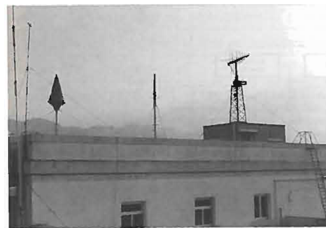
Fig. 2 — Sistema di antenne attualmente usato per il radiomonitoring dell'intervallo in frequenza 20-1000 MHz.
