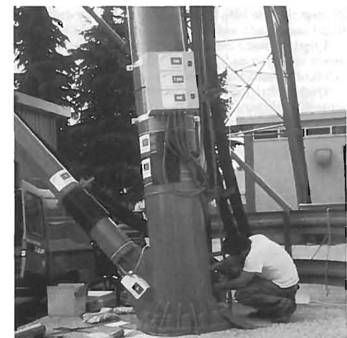
Fig. 5 — Vista della UA e dei punti di fissaggio sia estensimetrici che di spostamento.
