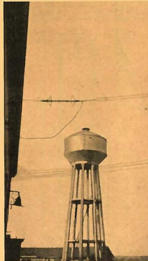
Fig. 14. — Serbatoio idraulico da 60 tonnellate e isolatore di ritenuta della coda.
