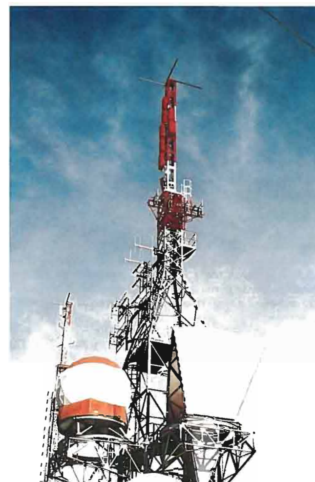
Fig. 18 — Centro trasmettente della RAI a Saint Vincent; si notino sul traliccio i sistemi radianti in polarizzazione verticale e orizzontale — banda III del sistema DAB.
