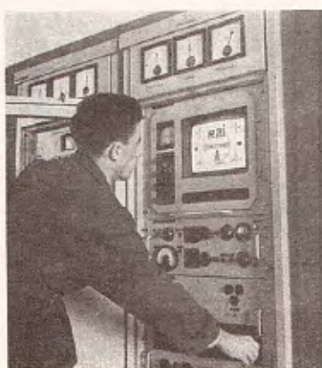
Ricetrasmittitore Siemens - Halske del collegamento televisivo a rimbalzo Milano-Roma, installato presso il centro di Monte Serra.
