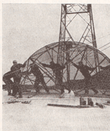
Montaggio del parabolide da 8 metri di diametro del terminale trasmettente del ponte radio a microonde tra Monte Argentario e la Sardegna.
