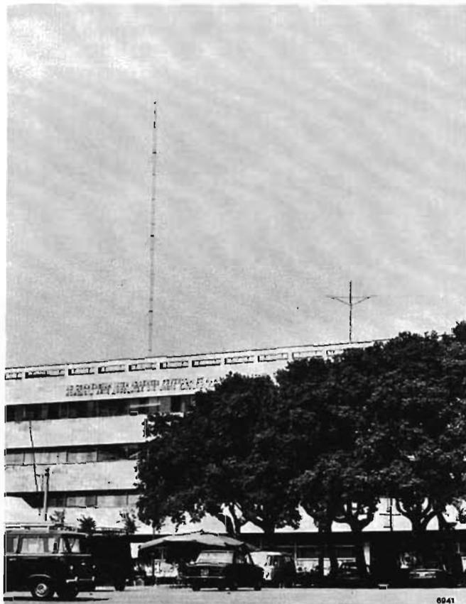
Fig. 48. — Confronto fra antenna convenzionale ed ad elica poste sul palazzo delle poste di Alessandria. I valori medi dei campi misurati in città e in periferia risultano inferiori di solo  $1,8 \div 2$  dB rispetto a quelli ottenuti con l'antenna di tipo marconiano. A sinistra nella foto, alta 30 metri.
